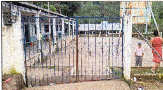
FOTO 11: Mantenimiento a portones de metal de rejas
