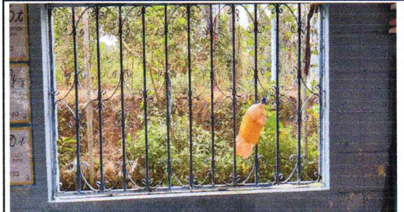
FOTO 10: Fabricación e instalación de balcones de hierro en ventana
