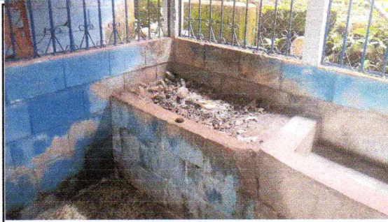
FOTO 7: Sustitución de estufa rural (completa) incluye chimenea y plancha de metal
