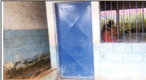
FOTO 3: Mantenimiento a estructura (lijado, cambio de tubo , cepillado, sujeciones, aplicación de pintura)
