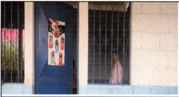
FOTO 5: Mantenimiento a balcones de metal
