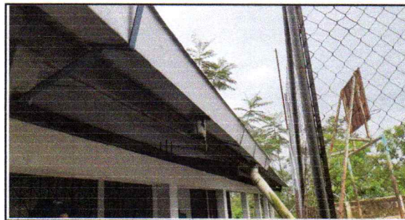
FOTO 6: Sustitución de canal de metal Y Reparación de bajada de agua pluvial, tubo PVC 3"
