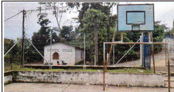
FOTO 12: Reparación de tubo hg y malla galvanizada
