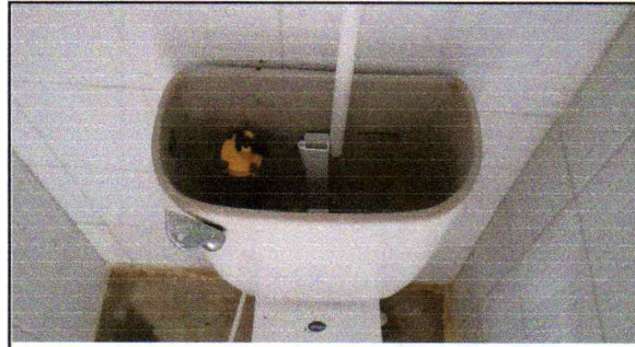
FOTO 2: Sustitución de accesorios inodoro (contra llave, tubo de abasto y tanque)
