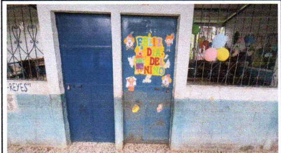
FOTO 8: Mantenimiento a estructura (lijado, cambio de tubo , cepillado, sujeciones, aplicación de pintura)
